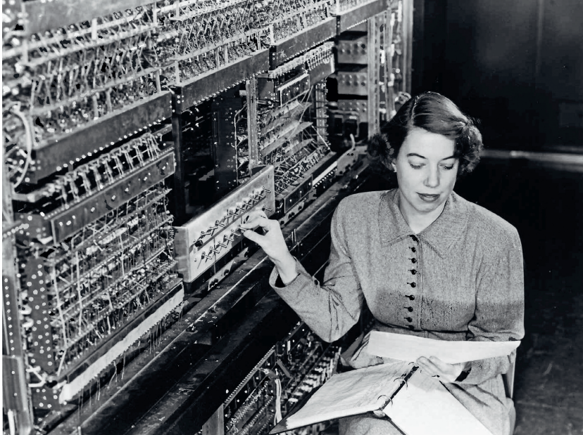
Abb. 21 | AVIDAC, der erste digitale Computer aus dem Jahr 1953. Preis: 250 000 US-Dollar
