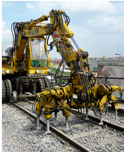
Abb. 14 | Menschen nutzen die Kräfte von hydraulisch gesteuerten Baggern.
